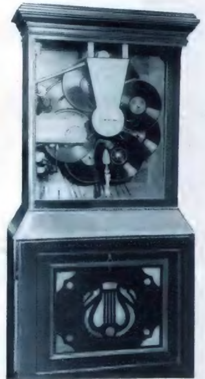
Ein neuartiges Radio-Grammophon, das auf der Erfinder-Ausstellung in London gezeigt wurde. Der Apparat gestattet es, 8 Platten hintereinander mit automatischer Wechsellung zu spielen. Berl. Jll. Ges.
